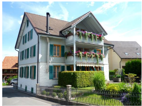
So sieht das alte Schulhaus heute aus Im Dörfli 10 in Finstersee
